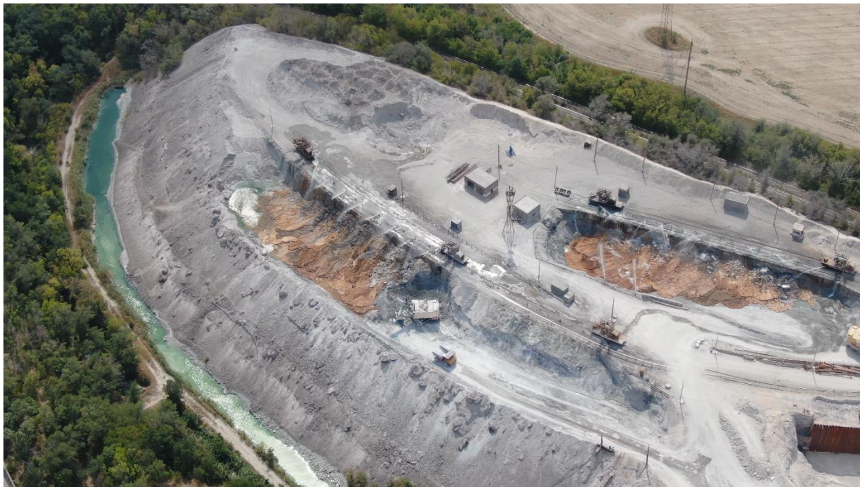
На фото шлакові відвали МК ММК ім.Ілліча, на яких зверху відбувається зрошування водою, 2020 . Джерело: Максим Бородін, особистий архів.
