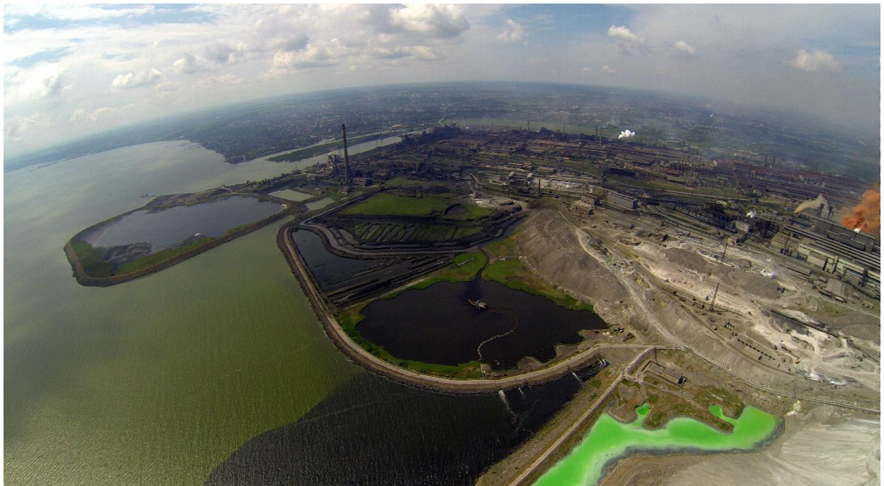
На фото шламонакопичувач (по центру) та золонакопичувач (озеро зліва зверху)
