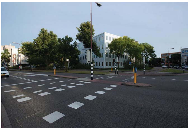
Стандартне облаштування пішохідного переходу за допомогою дорожньої розмітки
