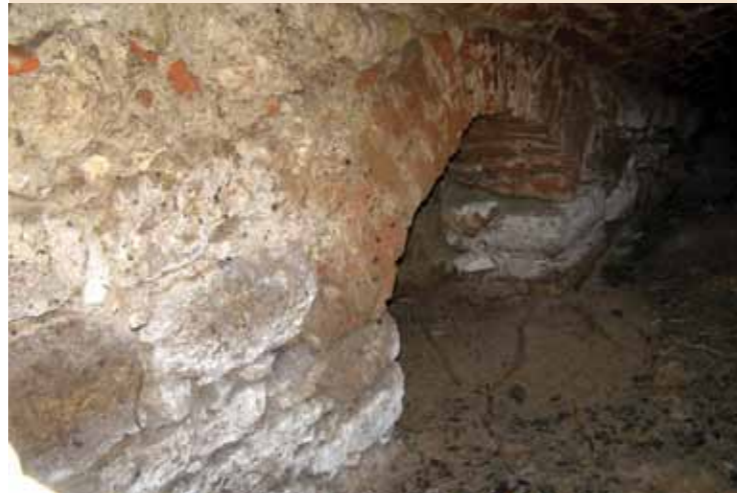
Фрагменти підземних ходів у нинішній Балті
