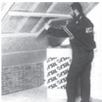
Рис. 6.5.1 Утеплення горіщного приміщення.
