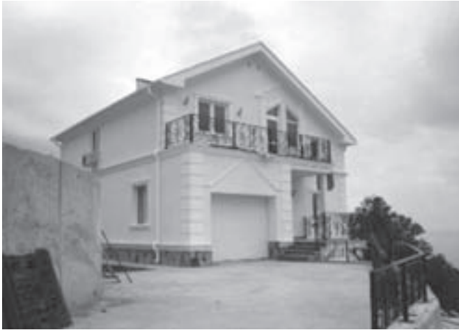
Рис. 6.5.11 Приклад утеплення фасаду штукатуркою «Тепловер».
