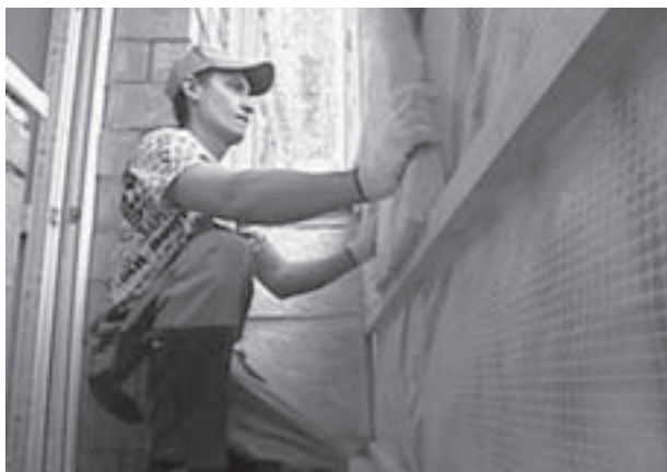
Рис 6.5.10 Утеплення фасаду мінераловатними плитами.
