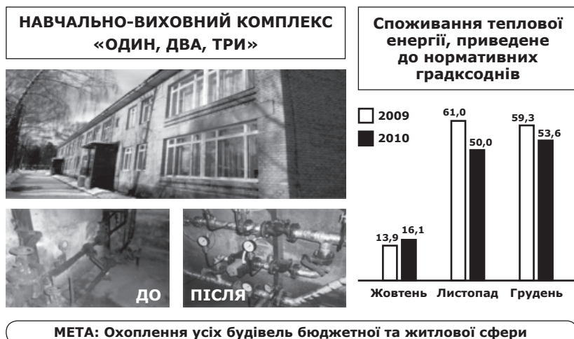
Мал. 4. Встановлення засобів обліку та регулювання подачі теплової енергії відносно зовнішньої температури повітря (на прикладі НВК «Один, два, три»)
